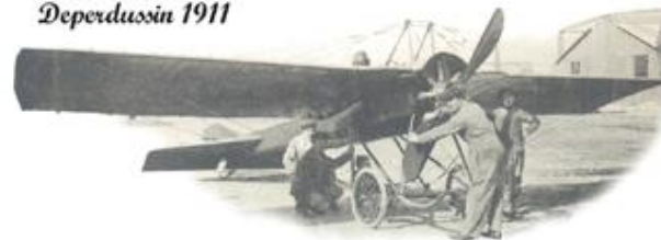
Moteur Gnome 50 chevaux, hélice bipale en bois fabriquée par Paulin Ratier. Gnome 50 HP engine, two bladed wooden propeller made by Paulin Ratier.
